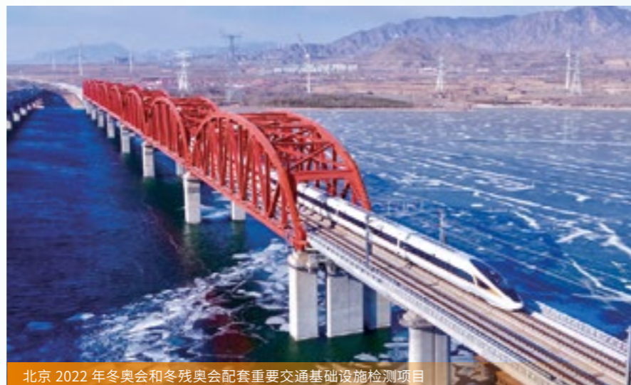
北京 2022 年冬奥会和冬残奥会延庆赛区临时设施项目
